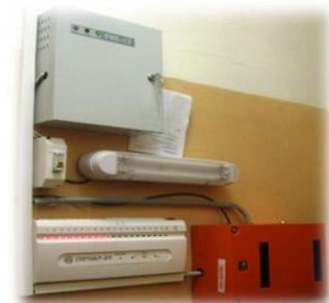
С целью обеспечения пожарной безопасности учреждения оборудованы АПС, имеют системы оповещения о пожаре, системы тревожной сигнализации, пожарное водоснабжение. Во всех учреждениях установлен программно-аппаратный комплекс «Стрелец-Мониторинг», обеспечивающий передачу сигнала о пожаре на пункт связи подразделений пожарной охраны.
